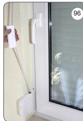
x) Vérifiez si toutes les connexions sont correctes. Faites un essai de fonctionnement du volet [97].
