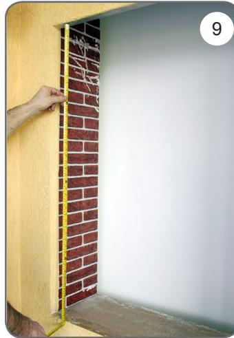
b) Vérifiez les dimensions : largeur et hauteur de la fenêtre [10], [11].
