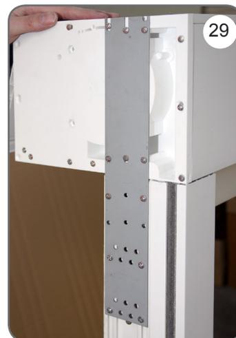
r) Après avoir vissé les connecteurs, placez le coffre perpendiculairement au châssis de fenêtre et vissez-le en faisant bien attention au positionnement de ces deux éléments. Il est possible d'utiliser ici les vis ou vis autoforeuses à tête plate susmentionnées, choisies convenablement en fonction de l'épaisseur du châssis de fenêtre, de façon à obtenir une jonction optimale entre le volet et la fenêtre [28], [29].
