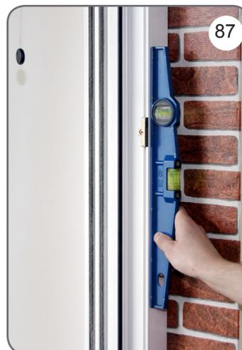
t) Le montage d'une fenêtre munie d'un volet doit être effectué conformément aux normes en vigueur et selon les règles de l'art. Installez la fenêtre avec volet dans la baie de montage à l'aide des ancres ou des vis selon les recommandations du fabricant de cette fenêtre [85], [86], [87].
