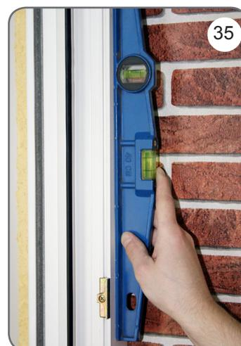
t) Le montage d'une fenêtre munie d'un volet doit être effectué conformément aux normes en vigueur et selon les règles de l'art. Installez la fenêtre avec volet dans la baie de montage à l'aide des ancres ou des vis selon les recommandations du fabricant de cette fenêtre [33], [34], [35].
