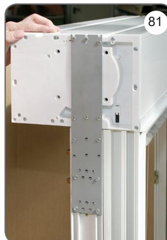
r) Après avoir vissé les connecteurs, placez le coffre perpendiculairement au châssis de fenêtre et vissez-le en faisant bien attention au positionnement de ces deux éléments. Il est possible d'utiliser ici les vis ou vis autoforeuses à tête plate susmentionnées, choisies convenablement en fonction de l'épaisseur du châssis de fenêtre, de façon à obtenir une jonction optimale entre le volet et la fenêtre [80], [81].
