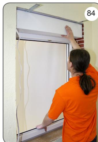
s) En fonction du mode de pose d'une fenêtre avec volet dans le linteau, installez un nombre convenable d'ancres de montage **KMO** dans les niches du profilé supérieur du coffre **PSG** [82], [83], [84].
