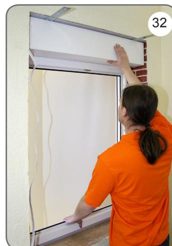
s) En fonction du mode de pose d'une fenêtre avec volet dans le linteau, installez un nombre convenable d'ancres de montage **KMO** dans les niches du profilé supérieur du coffre **PSG** [30], [31], [32].
